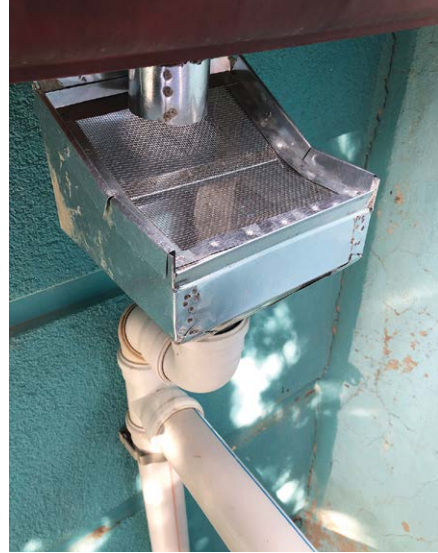
Şekil 11 ve 12: Solda, kaba filtre ve tortu ayırıcı ile bağlanmış ve taşma borusu da unutulmamış bir yağmur suyu deposu. Sağda, filtrenin detaylı görünümü.
