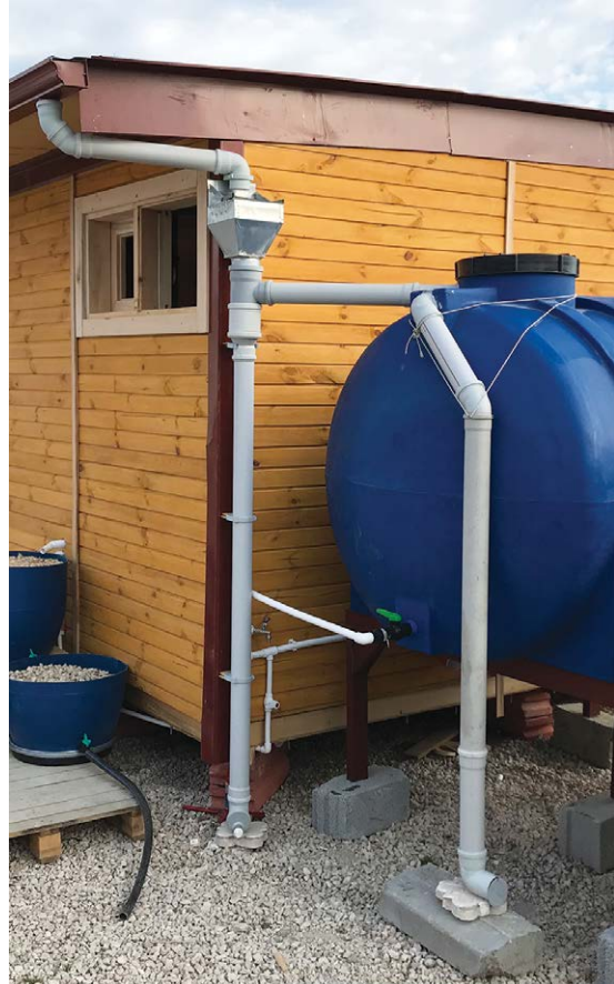
Şekil 8, 9 ve 10: Çatı olukları vasıtasıyla yağmur suyu hasadı.
