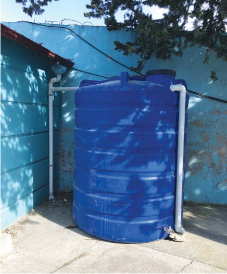
Şekil 11 ve 12: Solda, kaba filtre ve tortu ayırıcı ile bağlanmış ve taşma borusu da unutulmamış bir yağmur suyu deposu. Sağda, filtrenin detaylı görünümü.
