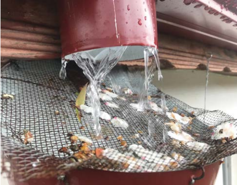
Şekil 8, 9 ve 10: Çatı olukları vasıtasıyla yağmur suyu hasadı.
